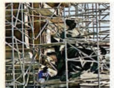
■ Un andamio fue ubicado alrededor de la estructura construida a principios del siglo 20.
