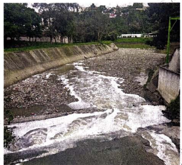
El olor que despiden la Presa El Capulín ha ido en incremento debido a la temporada de calor.
