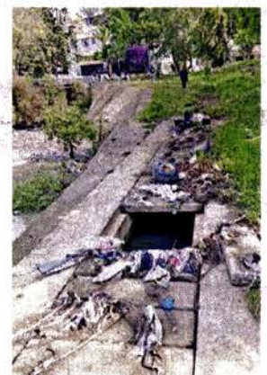
El Ayuntamiento espera que en unos días la Conagua desazolve el vaso regulador.
