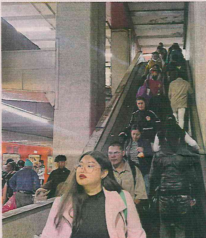
■ Usuarios terminan usando los equipos apagados como escaleras idé doble sentido!
