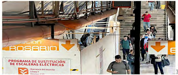
COMO SI FUERAN ETERNAS. Las obras de sustitución de escaleras se han extendido por más de dos meses en cinco estaciones de tres líneas distintas.
