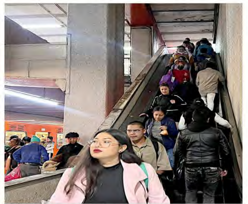
Usuarios terminan usando los equipos apagados como escaleras de doble sentido!
