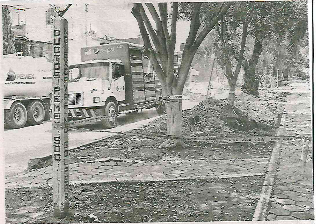
A lo largo de este ducto se hacen las tareas de excavación, es decir, se deja al descubierto el ducto con el objetivo de ubicar si existe algún tapón /DAVID DEOLARTE
