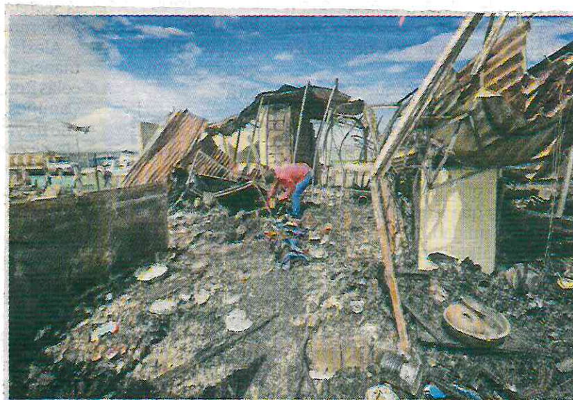
El fierro que recuperan lo venderán por kilo para enfrentar los daños.
