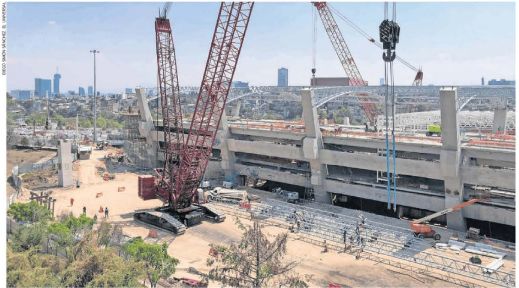
En la terminal Observatorio ya es visible la infraestructura que albergará los andenes para el arribo de los convoyes de El Insurgente, constató EL UNIVERSAL en un recorrido.
