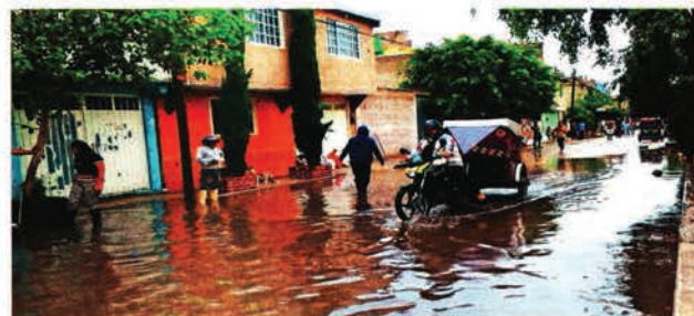
El dren Chimalhuacán II se fracturó en su intersección con el río de La Compañía, por lo que viviendas de las calles 7, 8, 9, 13, 14 y 17 de la colonia Arturo Montiel se anegaron de aguas negras.
