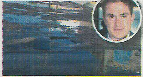
· Las calles en la zona están repletas de baches
