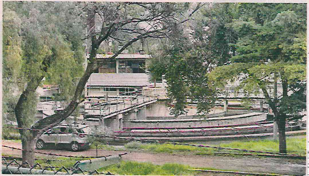
■ La Planta de Tratamiento de Aguas Residuales comenzó a operar hace cinco años.
