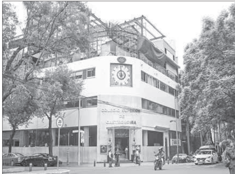
▲ En el edificio ubicado en Sonora 189, colonia Hipódromo, que alberga al Colegio Superior de Gastronomía, se trabaja a marchas forzadas para
