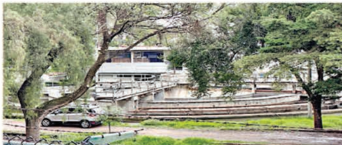
La Planta de Tratamiento de Aguas Residuales comenzó a operar hace cinco años.
