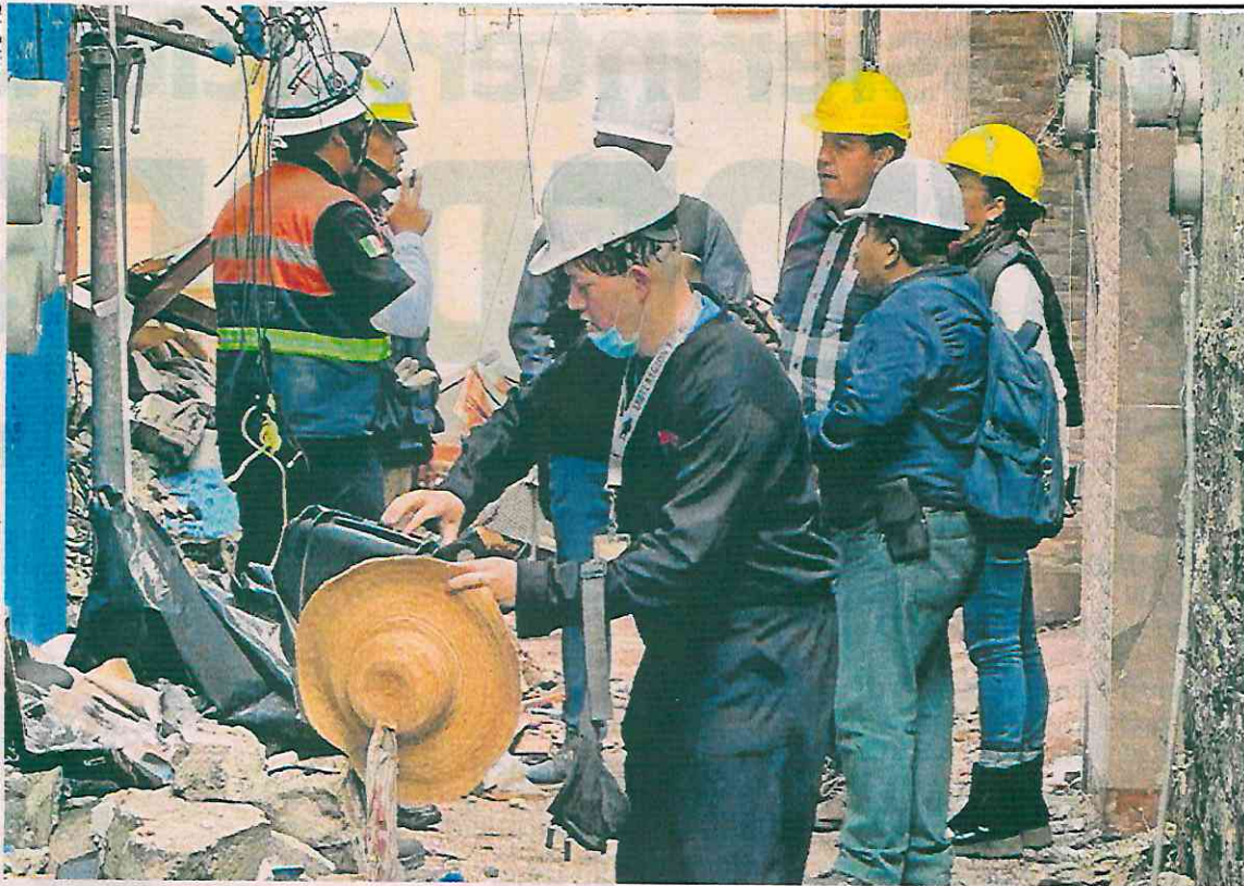
La alcaldía Coyoacán informó que la empresa contratada para el apuntalamiento del inmueble dañado, permitió que ayer pudieran entrar seis peritos de la fiscalía capitalina para concluir con el peritaje.
