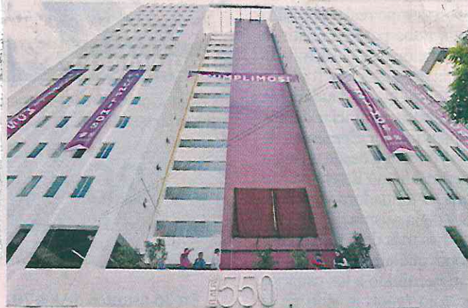
La CDMX entregó ayer la reconstrucción del complejo habitacional en Tlalpan 550, en la Colonia Moderna.
