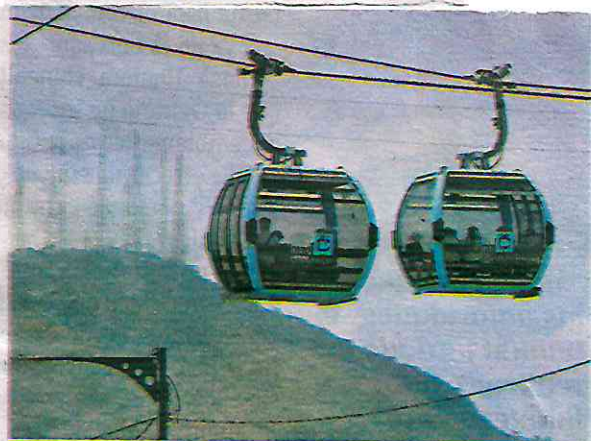
Durante dos semanas se han efectuado trabajos de mantenimiento /SERGIO VÁZQUEZ
