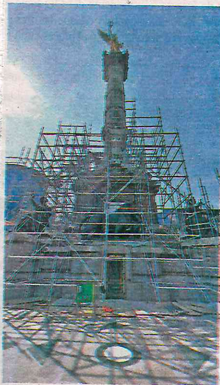
Realizarán trabajos de limpieza y restauración en el basamento y las esculturas /CORTESÍA: SRIA. DE CULTURA
