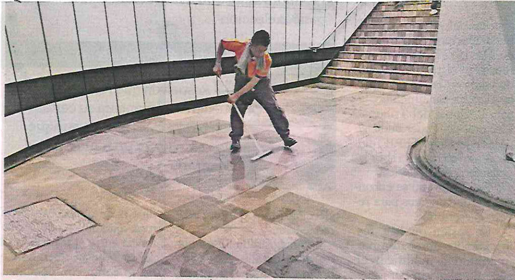
De acuerdo con personal del STC, las obras de reparación pueden tardar hasta dos semanas.
