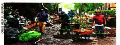
Cuadrillas del Gobierno capitalino realizaron la limpieza del fraccionamiento y desazolve de las coladeras.
