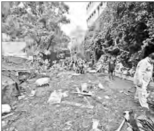
▲ Empleados del Sacmex y de Protección Civil acudieron a realizar la limpieza de la zona. Foto Yazmín Ortega Cortés
