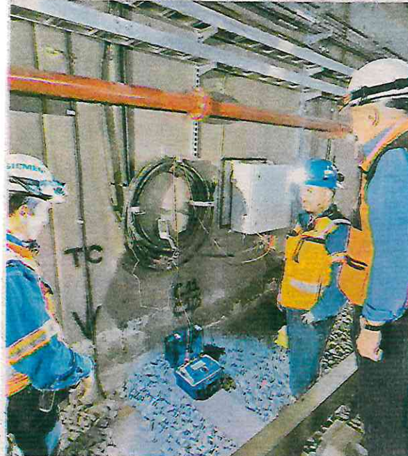
Los trabajos buscan renovar por completo la infraestructura de la línea más antigua del Metro
