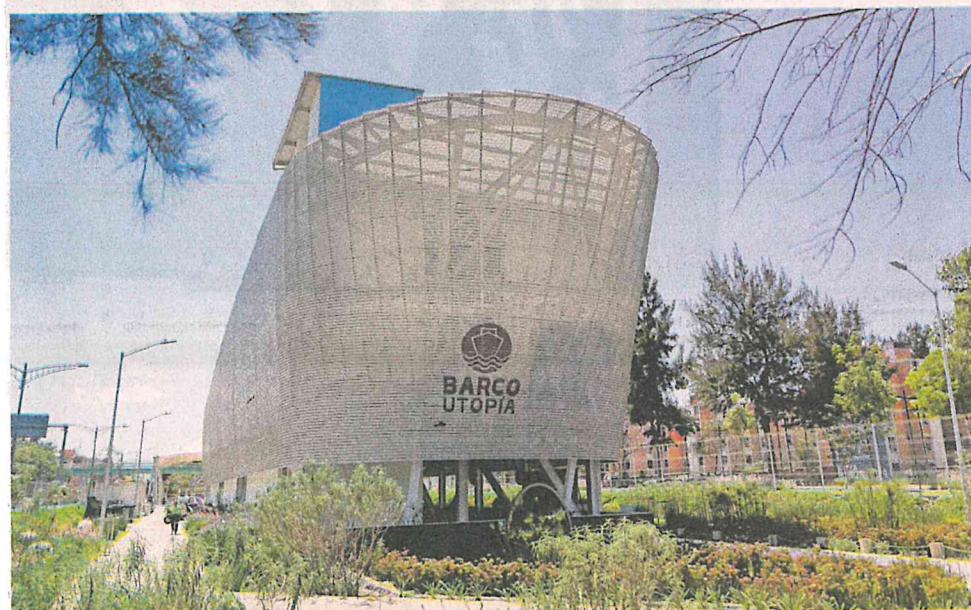
Barco Utopía, localizada en la unidad habitacional Vicente Guerrero y cuenta con un acuario virtual, recibió un millón 299 mil 190 pesos para mantenimiento menor.
