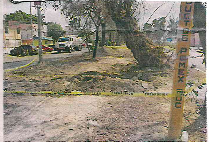
En otros puntos, la tierra fue removida para detectar fugas.
