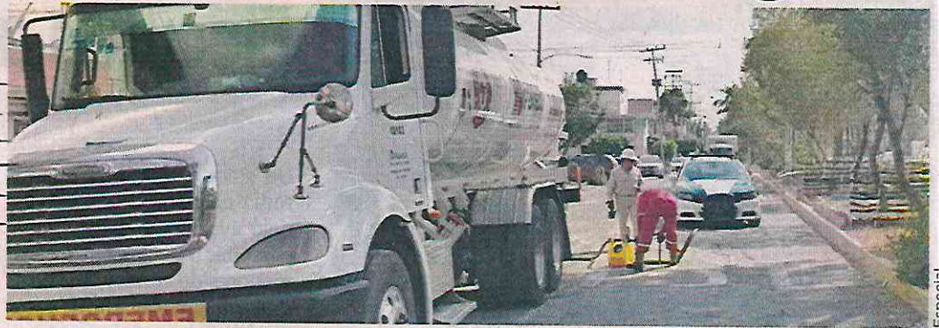
■ Cuadrillas de Pemex y de SGIRPC limpiaron colectores de desagüe en la zona.
