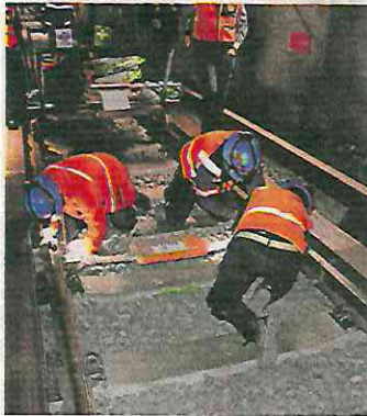
En el tramo Sevilla-Chapultepec ya se terminó el sistema de vías.
