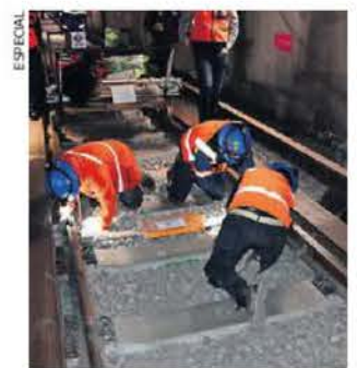
En el tramo Sevilla-Chapultepec ya se terminó el sistema de vías.
