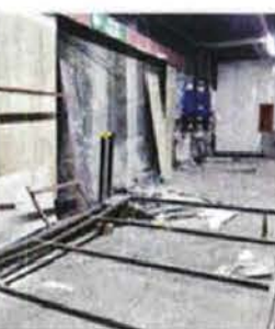
Los trabajos debían concluir en agosto de 2023.
