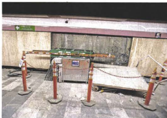
Se repararon más de 2 mil 500 filtraciones y se sustituyeron 2 mil kilómetros de cableado de energía eléctrica, dijo el director del Metro.
