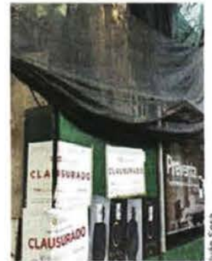
En Jalapa 89 fueron colocados sellos a una obra irregular.
