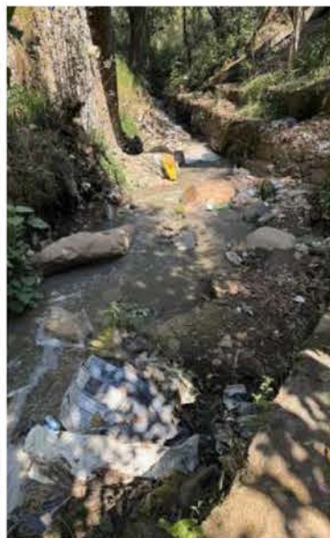
Limpieza de la Presa San Francisco.
