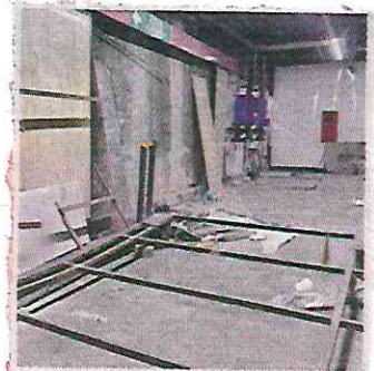
Los trabajos debían concluir en agosto de 2023.
