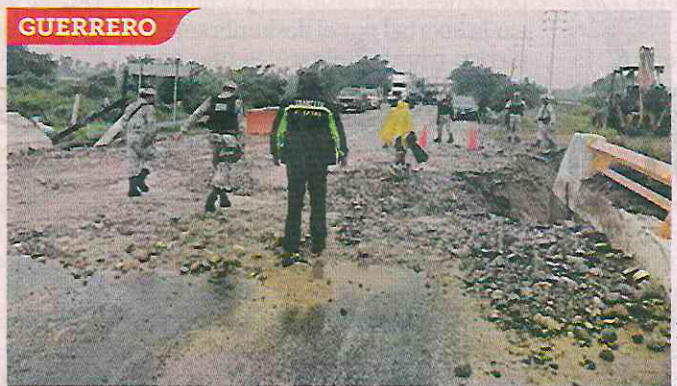
■ Militares y elementos de Tránsito de Guerrero durante las inspecciones del puente de Viaducto, en Acapulco.
