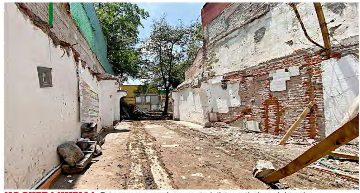
NO QUEDA HUELLA. Esta semana, camiones materialistas retiraban el desecho que generó la demolición en Calle Reyna.
