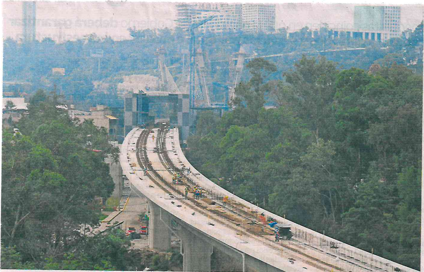
En el tramo elevado se realizan trabajos preliminares para la inserción de plintos y vía en el frente de obra Industria Militar.
