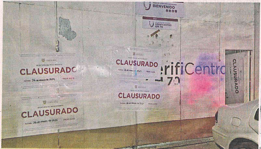
El verificentro GM-70, cercano a la Basílica de Guadalupe, fue clausurado por la Sedema, tras acreditarse las irregularidades en la operación. Sellos fueron colocados en la fachada del inmueble
