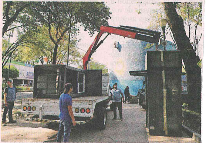
Estructuras publicitarias sin autorización y que eran usadas para otros fines también han sido desmontadas.
