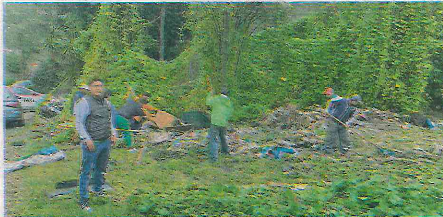
Las acciones se centran en trabajos de desazolve y retiro de basura y materiales de arrastre /CORTESÍA: ALCALDÍA ÁLVARO OBREGÓN
