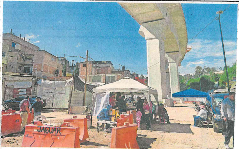
Vecinos de El Capulín han protestado por las obras del Interurbano.
